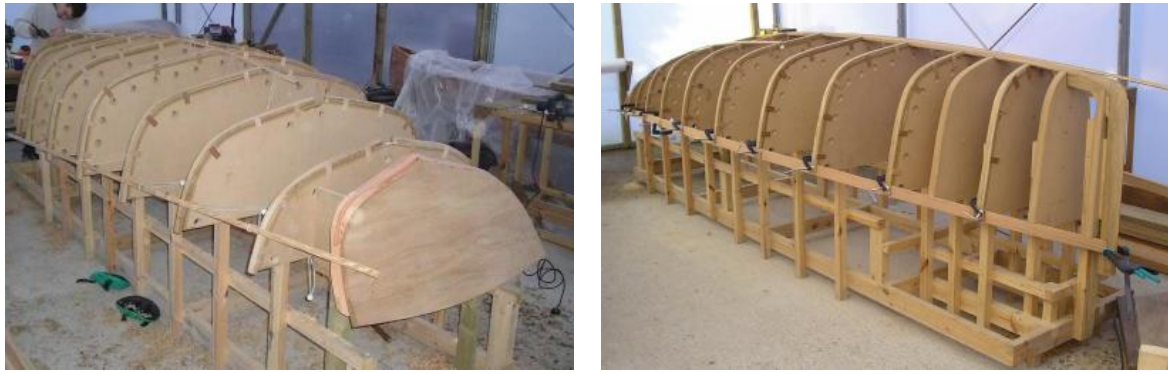
6.16. ábra: A bordaváz felállítása, a gerinc és a koszorúlécelhelyezése
