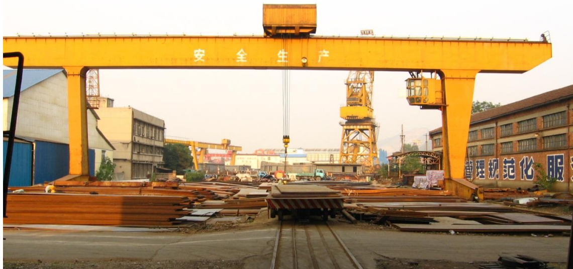
1.11. ábra: Alapanyag raktározás a Jinling hajógyárban (Nanjing, Kína)
