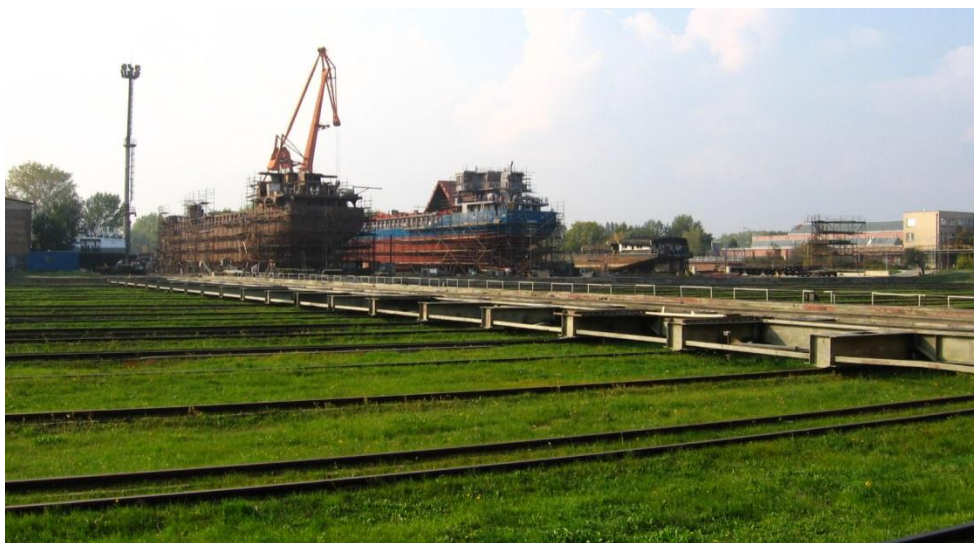
4.8. ábra: Keresztirányú sólyapálya az SLKB hajógyárban (Révkomárom, Szlovákia)
