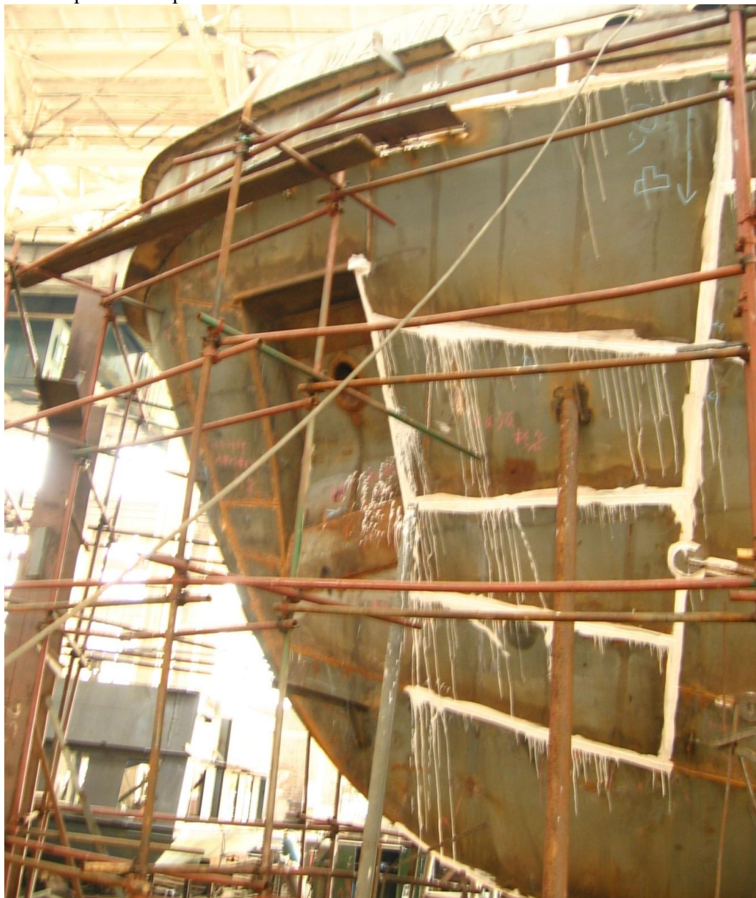
2.47. ábra: Hegesztési varratok ellenőrzése a Dajiang hajógyárban (Wuhu, Kína)
