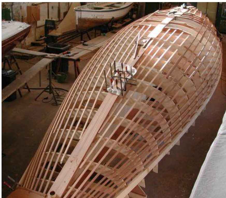
6.22. ábra: A belécezett váz, középen a benntartó fenekbordák
