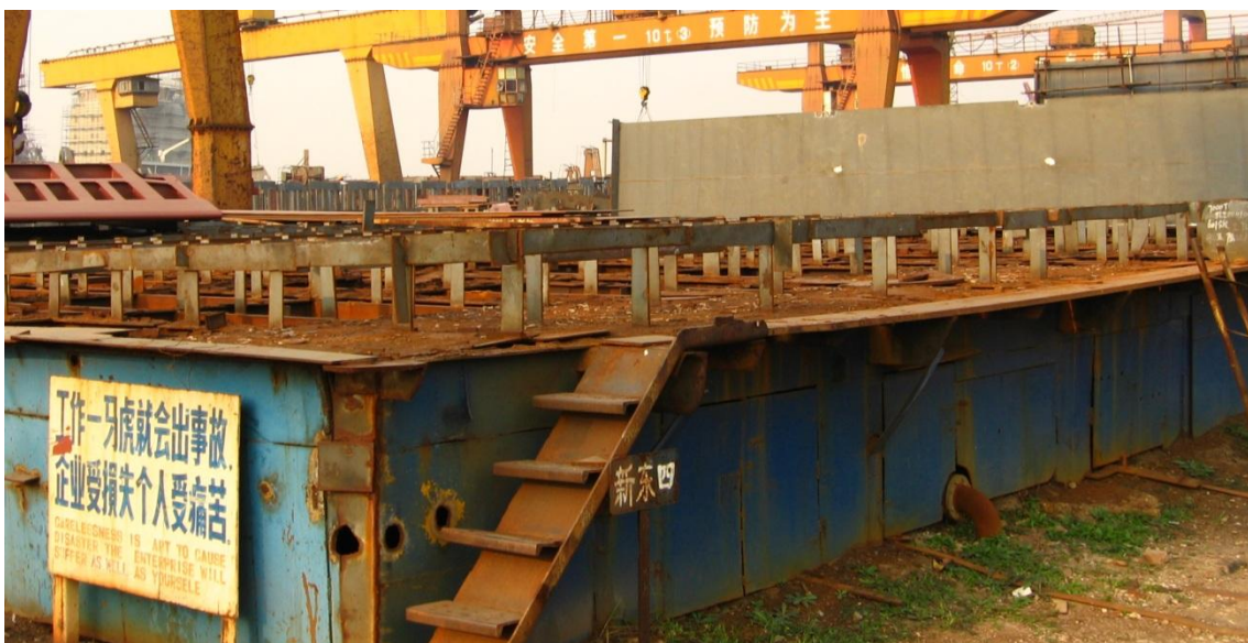
3.11. ábra: Szekcióépítő padozat a Jinling hajógyárban (Nanjing, Kína)
