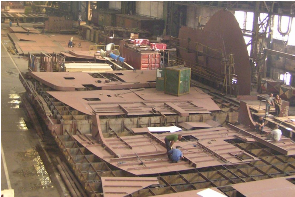
3.4. ábra: Síkszekcióépítő padozat az SLKB hajógyárban (Révkomárom, Szlovákia)
