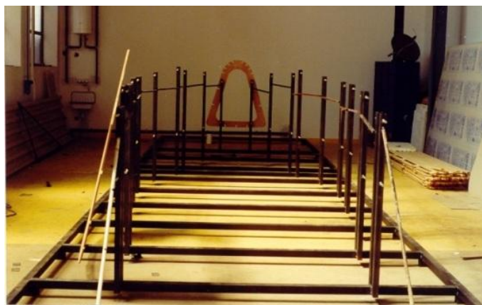
6.29. ábra: Építőállvány acélból
