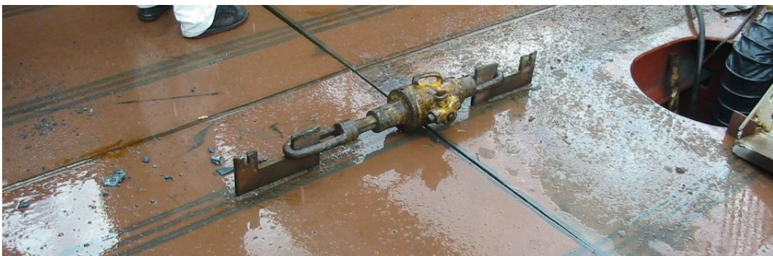
3.9. ábra: Szekciók összehúzatása a Május 3 hajógyárban (Rijeka, Horvátország)
